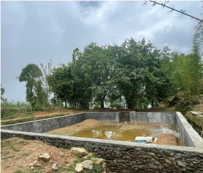
पानी संकलन पोखरी निर्माणधिन
